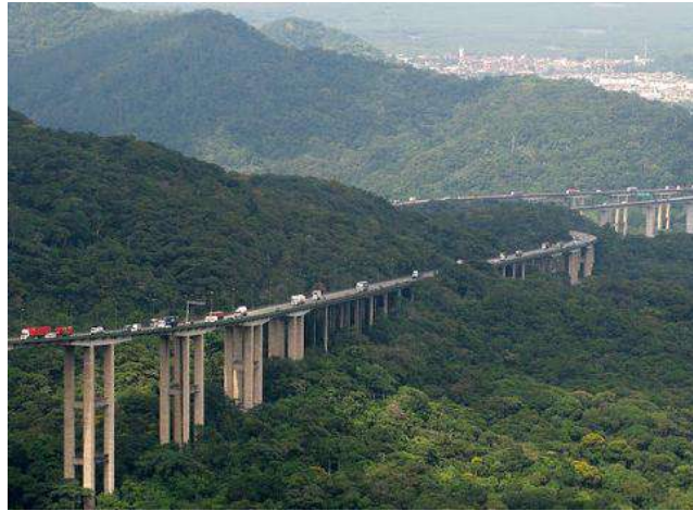
Jalan layang melalui di atas lembah, habitat fauna dan flora langka dan sekaligus berfungsi sebagai koridor satwa liar
